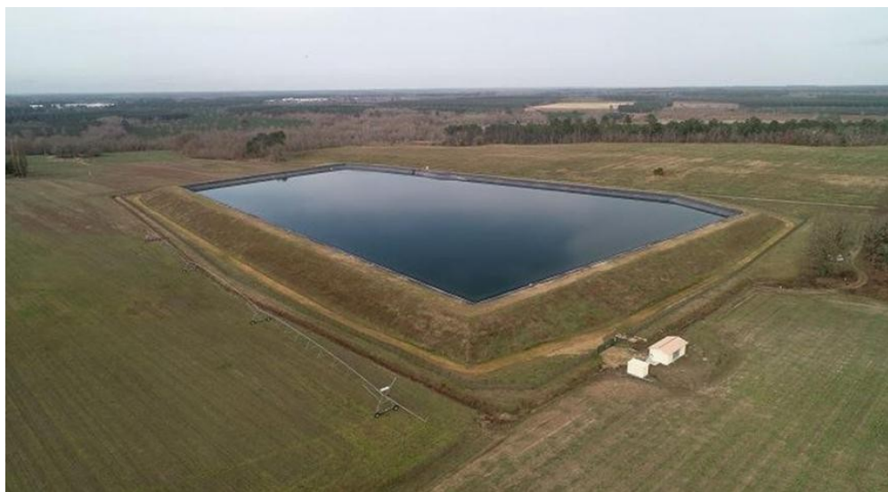
Photo du bassin de stockage à Mazerolles
