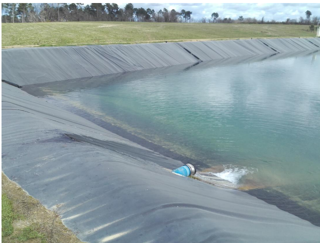
Figure 9 : Photographies du point de rejet
