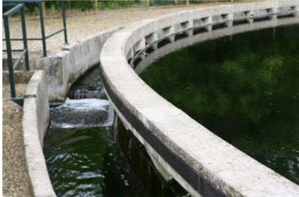
Station d'épuration de Jouanas - Sortie du clarificateur
