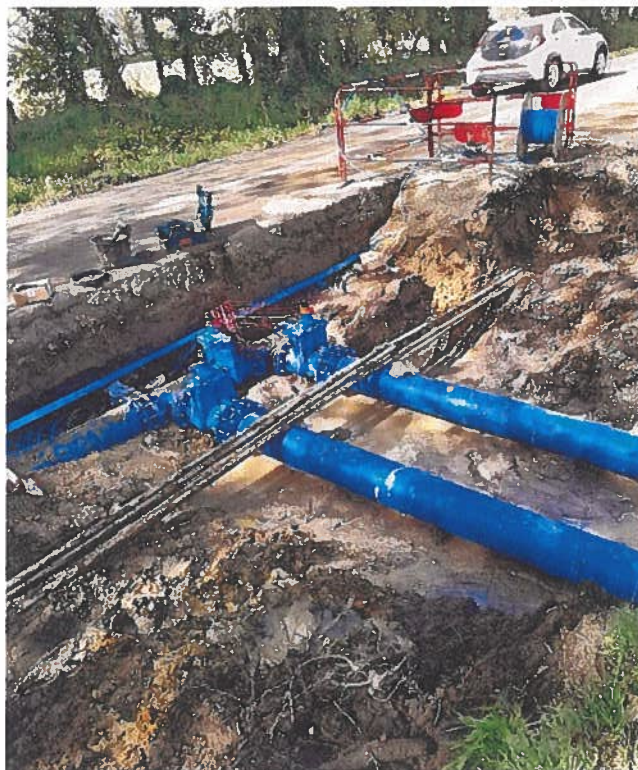
Pose de canalisation fonte
